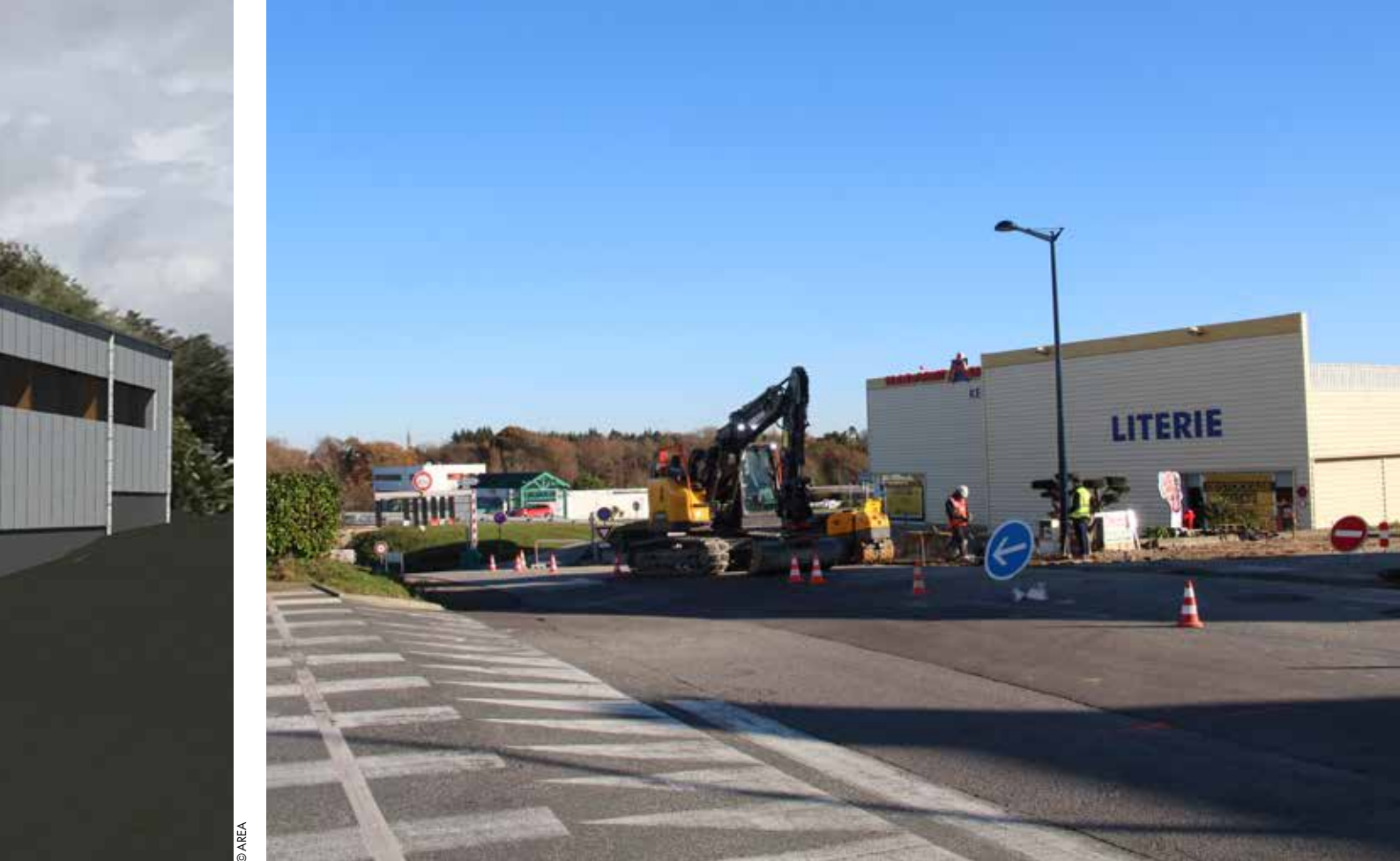
Mise en sécurité de la rue de Keriollet par l'aménagement d'un giratoire, la création de trottoirs, et le prolongement de la voie cyclable.
